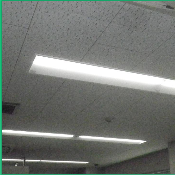
施工完了 LED照明設置完了
