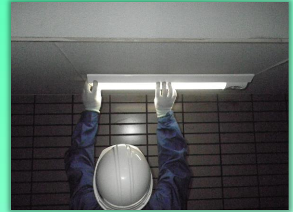
施工中 LED照明設置中
