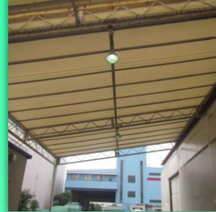
施工前 水銀灯
