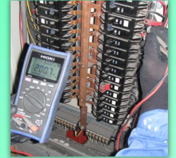
施工中 電圧確認
