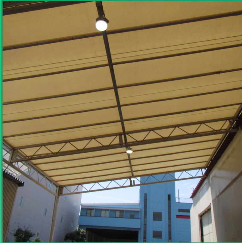
施工完了 LED照明設置
